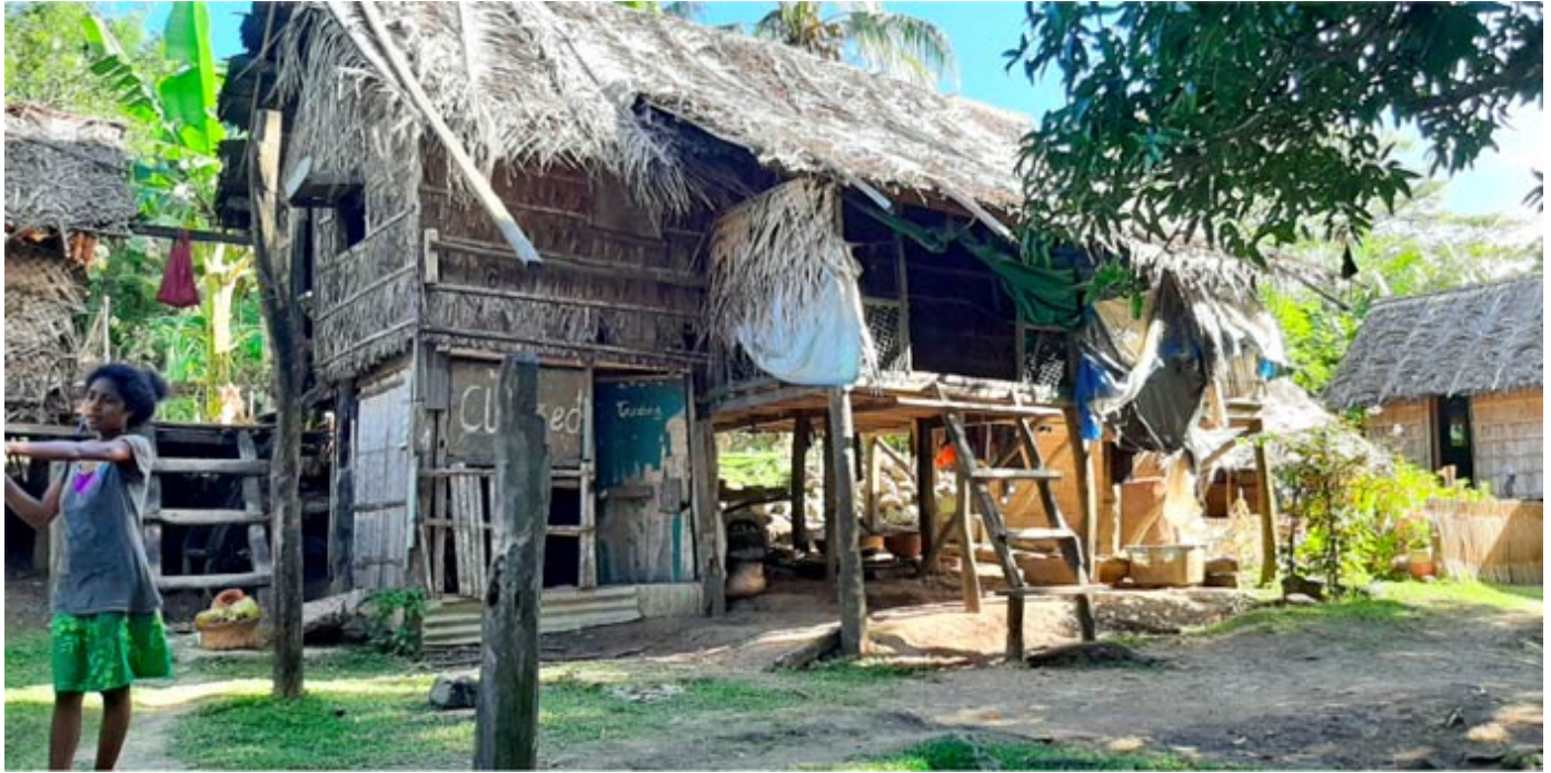
Le capanne hanno pareti di foglie di pandano intrecciate, e tetto di foglie di palma
